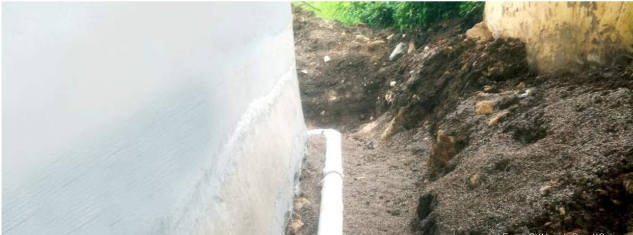
Freilegen des Mauerwerks und Herstellung einer Drainage
