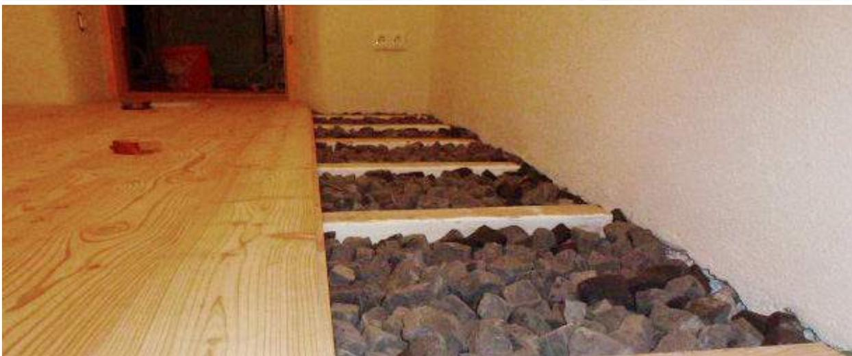
Der Fußbodenaufbau mit **GEOMATERIALS Schaumglas** eignet sich für Neubau und Sanierung. Besonders bei alten Gebäuden ist bei der Sanierung von Fußböden die verfügbare Aufbauhöhe begrenzt.
